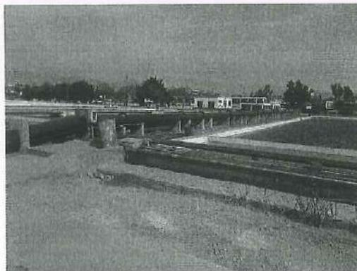
Foto N° 18: Tubería de impulsión proveniente de la planta de recuperación del lavado de filtros.
