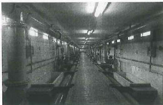
Foto N° 13: Tuberías de transporte de aire y agua del sistema de lavado de los filtros de la Planta N° 01.
