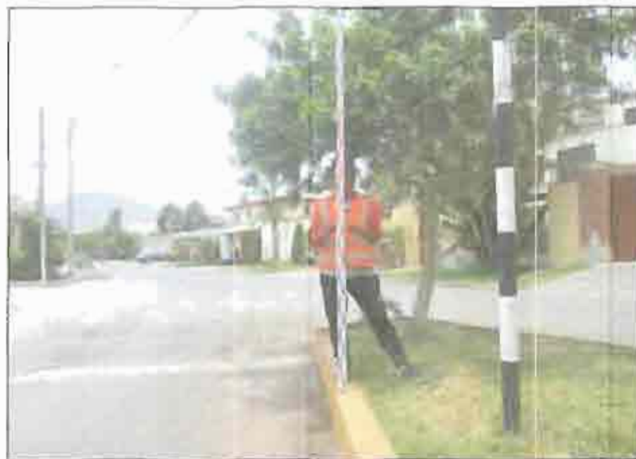
Foto 25 (Izquierda) vista panorámica del posicionamiento en el cambio C-25 en la Av. el Velero y Foto 26 (Derecha), Toma panorámica del punto de nivelación C- 26, sobre sardinel de la vía, ubicada en la intersección de las avenidas Las Redes y Velero..
