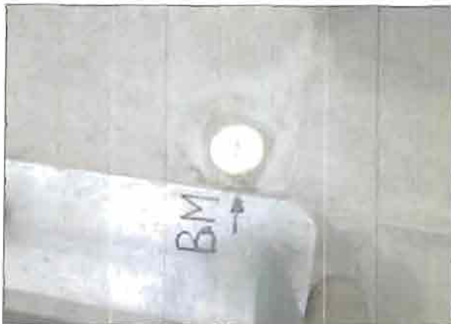
Foto 33(Izquierda) y Foto 34 (Derecha), Vista en acercamiento y panorámica del BM1 incrustada sobre la vereda, que corresponde a la cámara de Control, estructura de la cámara de desague existente en la Av. La Redes.
