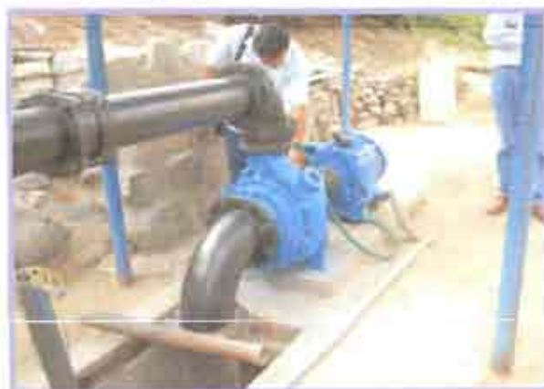
Electrobomba Centrífuga Horizontal
