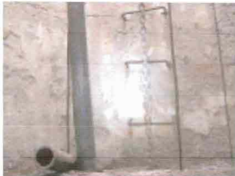
Vista fotográfica N° 03: se observa el interior de CB-14., a la altura de la parte intermedia de la cámara, se puede observar, las tuberías de F°F sin uso. Y el mal estado de los muros de concreto
