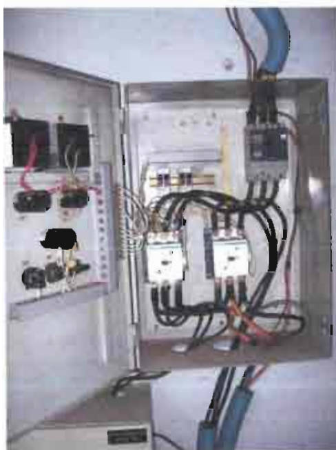
Fig. 2.2.- Tablero de transferencia.
