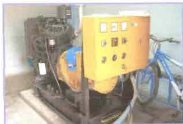
Grupo Electrónico y su Tablero de Control
