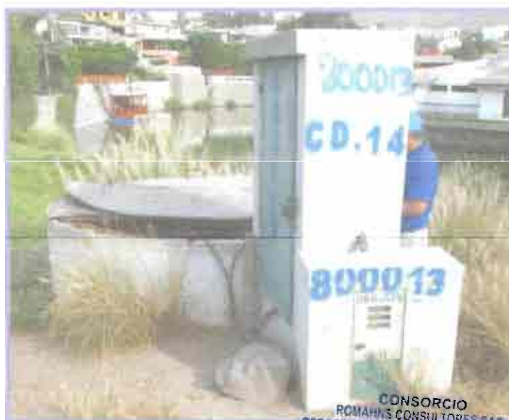
Cámara de Bombeo Semienterrada
