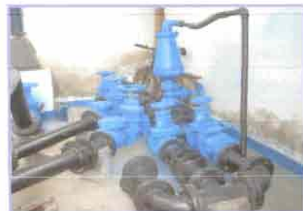
Árbol de descarga de las Bombas Sumergibles
