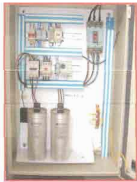
Parte Interna del Tablero de 02 Banco de Condensadores de 11kVAr-220V-Trifásico
