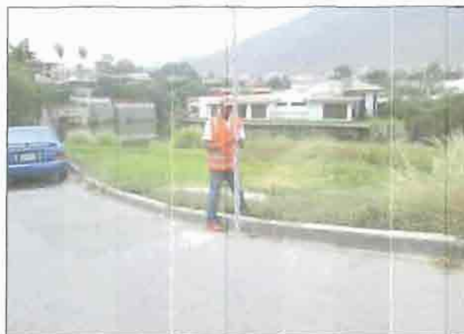
Foto 31 y Foto 32.- (Izquierda) Vista en acercamiento y panorámica del BM2, monumentada al costado del sardinel , cerca de la Cámara de Desague ubicada en la Calle la Fragata
