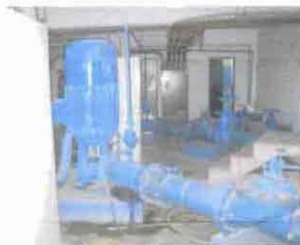
Se observa la cámara de bombeo (Booster)
