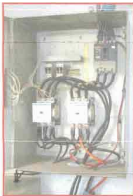
Parte Frontal e Interna del Tablero de Transferencia
