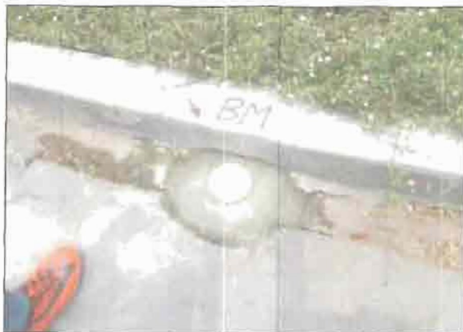
Foto 31 y Foto 32.- (Izquierda) Vista en acercamiento y panorámica del BM2, monumentada al costado del sardinel , cerca de la Cámara de Desague ubicada en la Calle la Fragata
