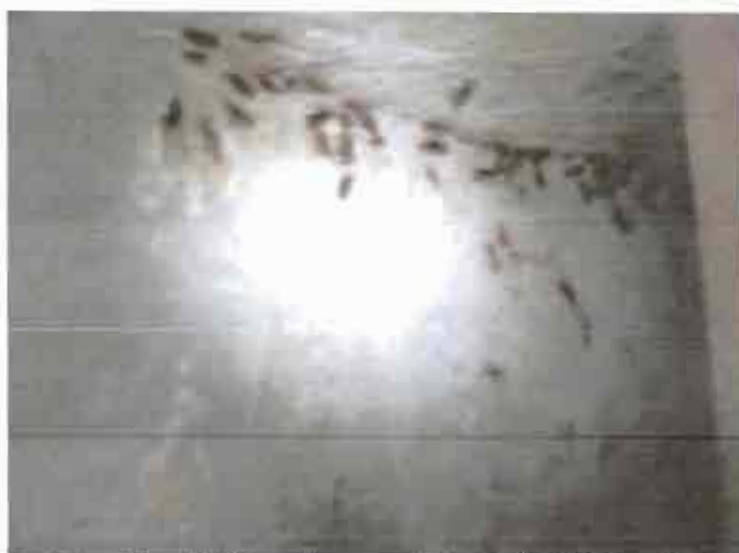
Vista fotográfica N° 06: se observa el interior de CB-14., a la altura de la parte baja de la cámara, donde el agua residual está en contacto con la superficie de la CB; se puede observar, el deterioro del muro de concreto.
