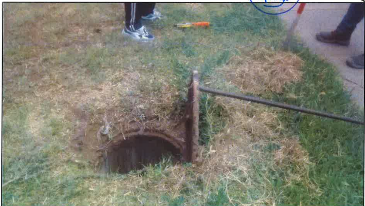
Vista del Buzón desagüe con tapa metálica frente a la zona de estudio (represado)
